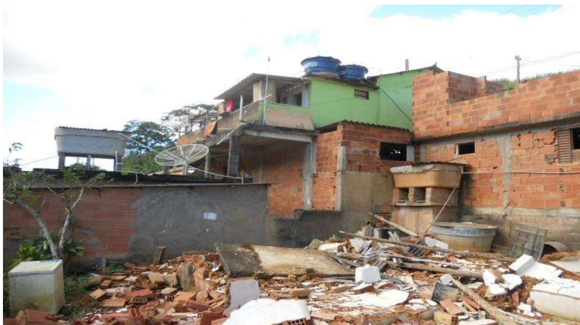
Figura 4: Foto de casas que foram destruídas com o deslizamento de terra ocorrido em 2012, no Morro Cristo Rei, Porciúncula, Rio de Janeiro Fonte: Defesa Civil do Município de Porciúncula (RJ).
